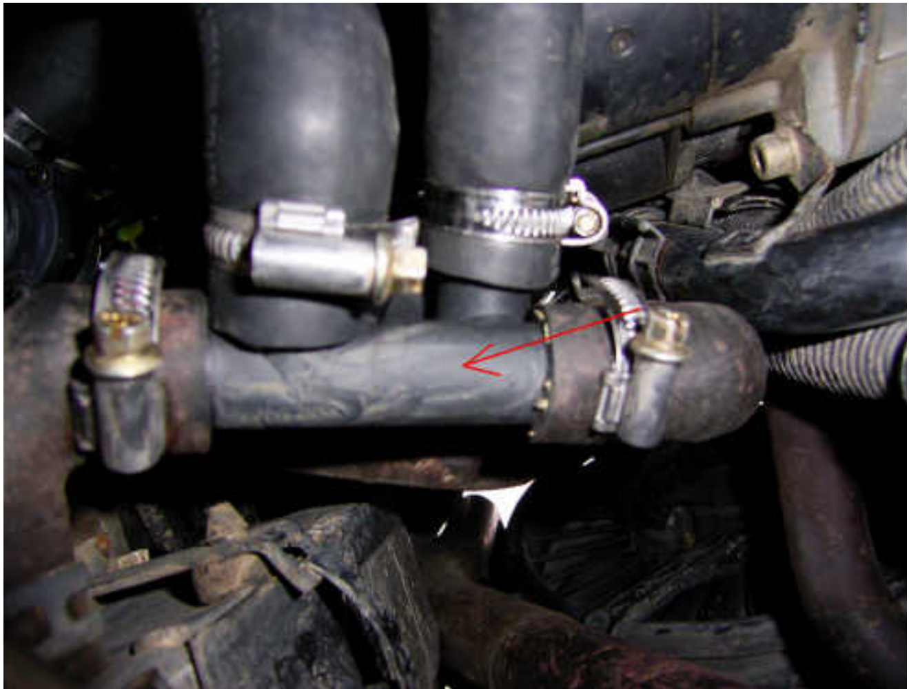
Les nouvelles durites en place vu de dessous (l'échappement de la chaudière est au premier plan):
