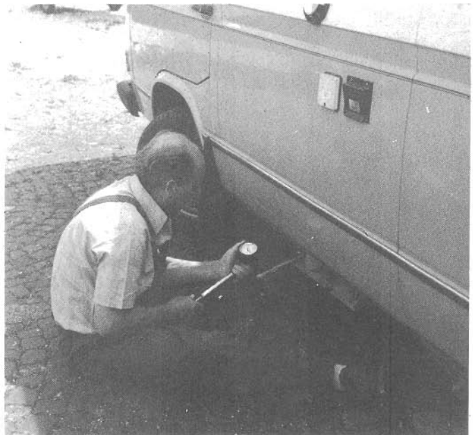
Gasprüfung bei einem Wagen mit Gastank. Der DVFG-Sachkundige drückt mit seiner Handpumpe die Gasanlage unter 3-fachem Betriebsdruck ab.
