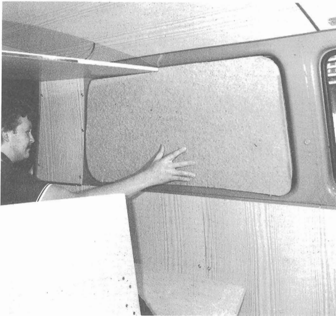
Die „blinde“ Seitenscheibe wird hier von innen isoliert.
