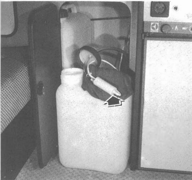
Die Tauchpumpe (Pfeil) fördert Wasser aus dem Kanister zum Wasserhahn. Einfacher und sehr funktioneller Aufbau der Wasseranlage.
