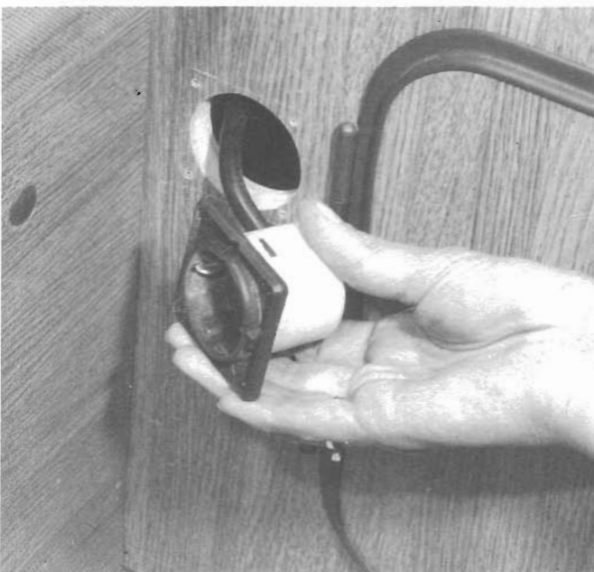
Diese Einbau-Innensteckdose hat einen Isoliertopf an ihrer Rückseite, damit man nicht von der Schrank-Innenseite her mit blanken Kontakten in Berührung kommen kann. Nur solche Dosen verbauen.
