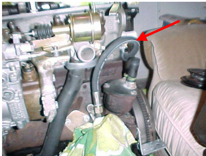
Neue Öldruckleitung zum Turbolader am Ölfilterflansch (Pfeil)...
