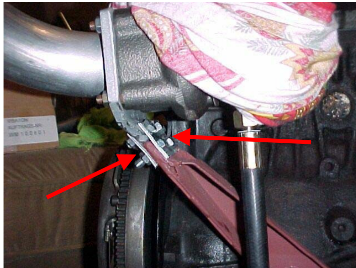
Die montierten Adapterbleche in der Seitenansicht (Pfeile)
